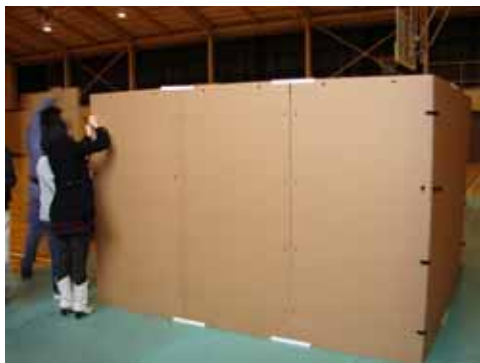
コーナー部をベルトで連結 2人1組で内から外へベルトを通す
