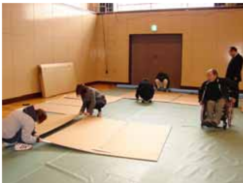
寝かせた状態で直線部を作る 直線部ができたなら、パネルを起こす
